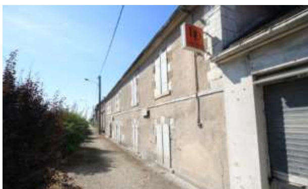
Bâtiment présent avant Doré Doré et intégré au mur d'enceinte (Perspectives, 2016)
