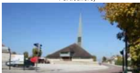
Eglise Sainte Agnès et son parvis en 2016 (avant travaux) (Perspectives, 2016)
