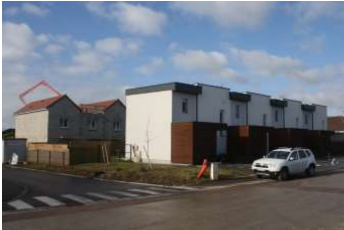
Exemple maisons individuelles groupées Le Moulinet, Pont-Sainte-Marie (10) Photo : Perspectives 2017
