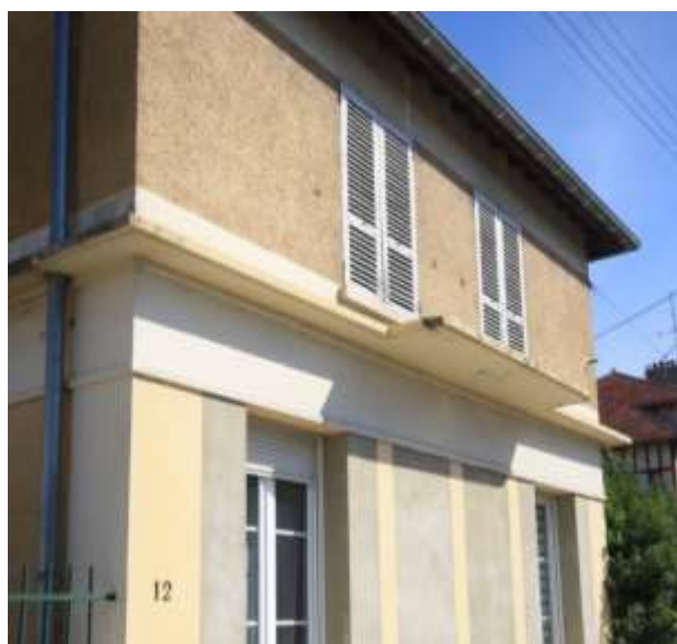
Marquise en béton (Perspectives, 2016)
