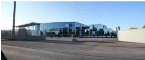
Entreprise Larbaletier à l'entrée Ouest de Fontaine
