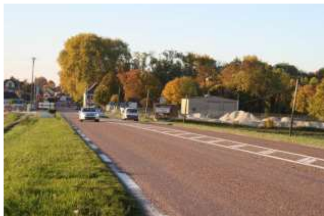
Entrée depuis la RD619
