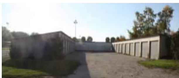
Garages collectifs rue du Stade (Perspectives, 2015)
