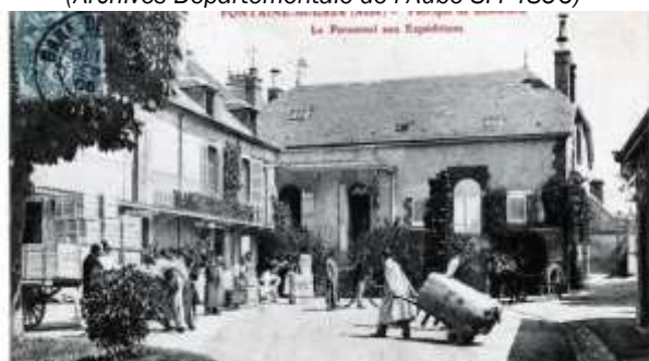
Photo ancienne de la cour intérieure du bâtiment à l'origine de Doré Doré (Archives Départementale de l'Aube 8Fi 4895)
