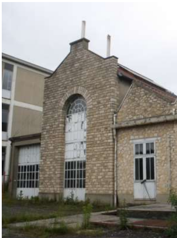
Façade Ouest de la chaufferie en 2016 (Perspectives, 2016)
