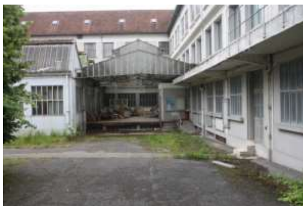
Bâtiment dit "le centenaire" et quai de chargement en 2016 (Perspectives, 2016)
