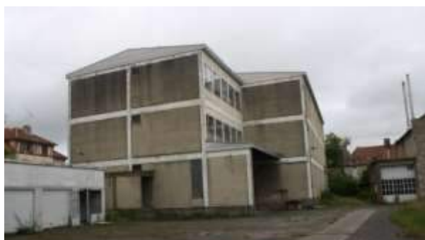
Bâtiments de stockage vus depuis le site (Perspectives, 2016)
