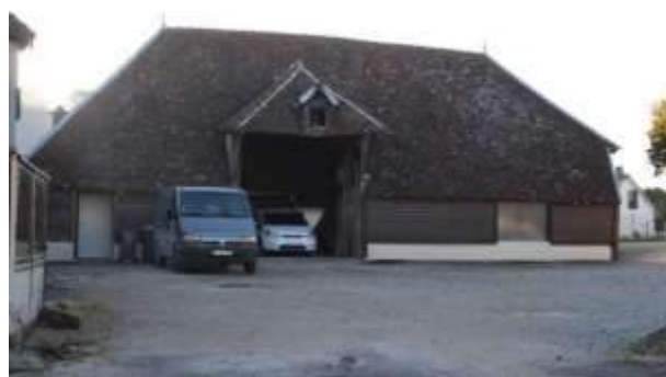
Bâtiment agricole, Fontaine, rue Saint-Georges
