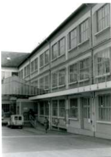
Bâtiment dit "le centenaire" et quai de chargement en 1986 (Région Champagne Ardenne Inventaire général, 1986)
