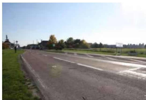
Entrée depuis la RD61, voirie large
