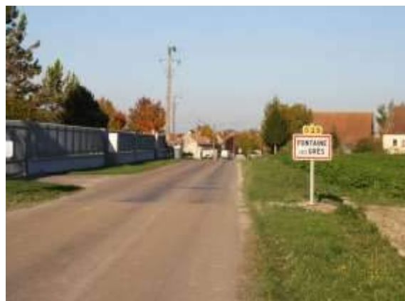
Entrée depuis la RD29
