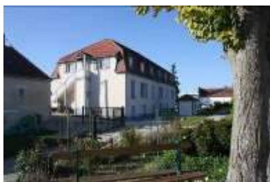
Maison à 10 logements, Avenue du Maréchal Foch
