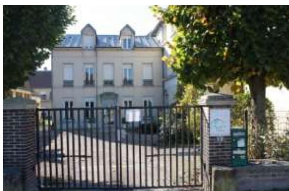
Bâtiment d'origine de la pension (Perspectives, 2015)
